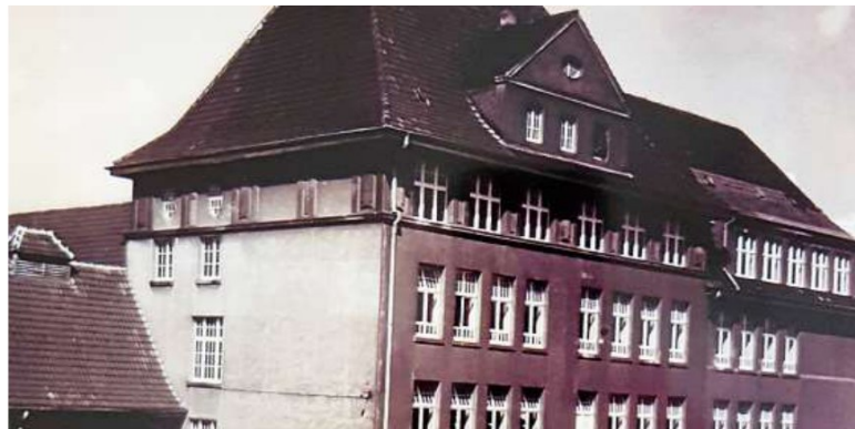
Das Foto zeigt den sogenannten Uraltbau der Theodor-Körner-Schule, also den ältesten Gebäudeteil, im Jahr 1950.
